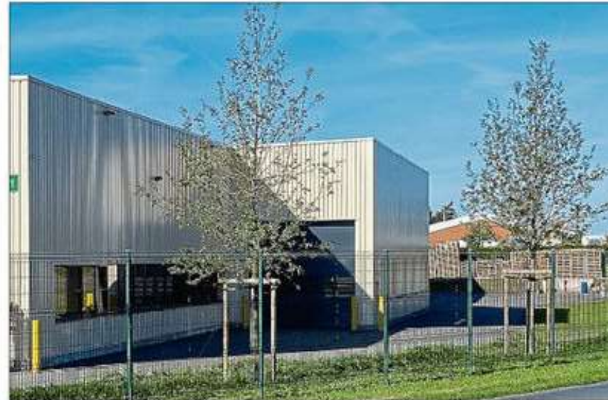
Erste Bäume: So wie Zerhusen Kartonagen Bäume an der Borringhauser Straße gepflanzt hat, soll es auch am Rand der neuen Gewerbefläche in Richtung Borringhausen geschehen. Foto: Lammert
